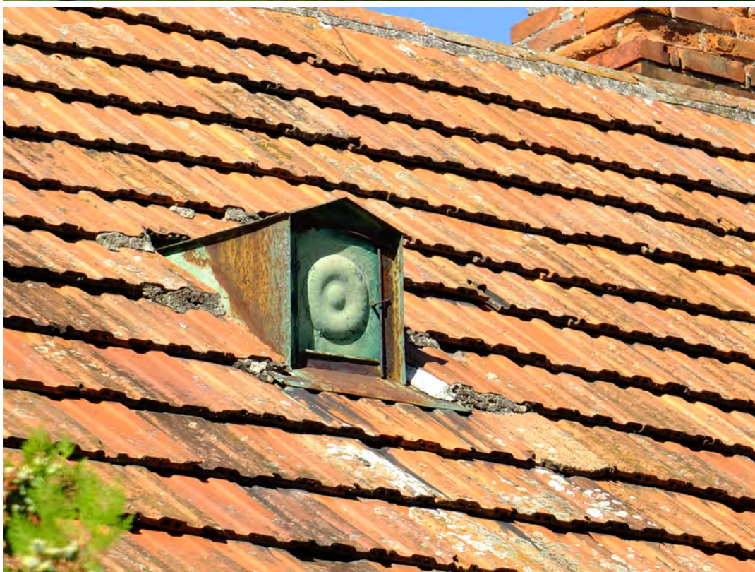
Példa tetőszellőzők bádogos mester által történt kialakítására
